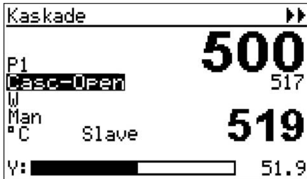
Fig. Kaskadenregler bei geöffneter Kaskade
